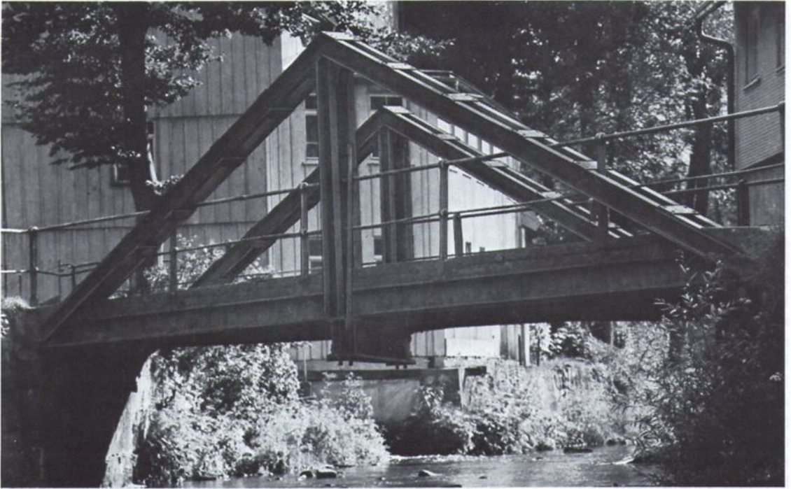
Abb. 14 Hängewerkbrücke bei Freudenstadt. Die Fahrbahn „hängt“ an der Dreiecks-konstruktion. Die lotrechten „Hängesäulen“ in der Fahrbahnmitte, die die Längsträger der Fahrbahn durch
